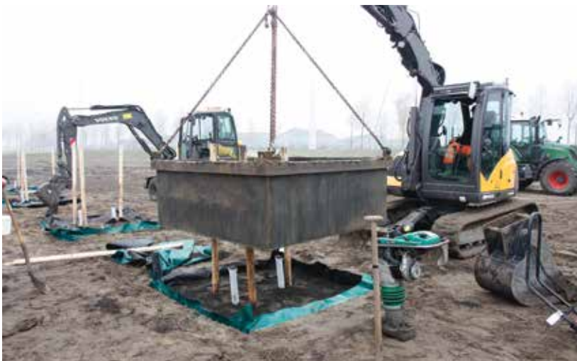
Een stalen mal zorgt ervoor dat de groeiplaatsen ingericht kunnen worden en allemaal precies even groot zijn. Bovendien is het zo mogelijk om het groeimedium goed te verdichten. Na de inrichting van de groeiplaats wordt deze 'bekisting' verwijderd.
