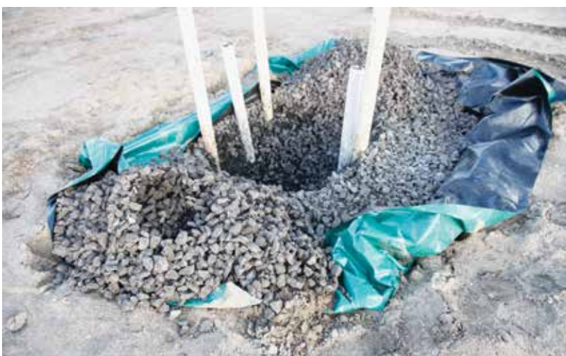
Een voorbeeld van een bomengranulaat. De mengsels verschillen in grootte van de stenen en soort materiaal (lavabrokken, verschillende soorten hardsteen). Ook in de voedingscomponent zijn verschillen (leem, compost, rivierklei et cetera). Zie tabel p.17.
