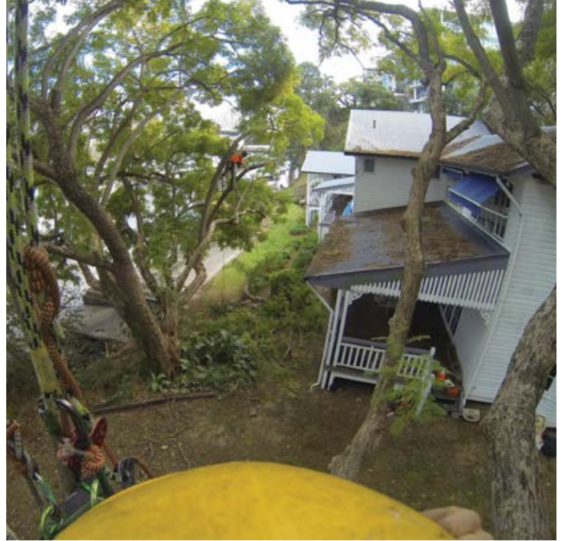
Snoeien van een Jacaranda over een dak
