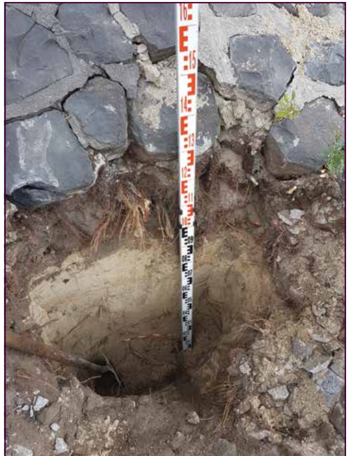
Tussen en net onder de basaltblokken zitten wat fijne wortels. Dieper in de kade liggen enkele wortels met diktes tot 5 cm.
