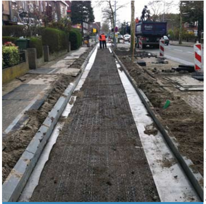
Aanbrengen permavoid
