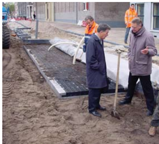
Prinsegracht, Den Haag, december 2005. Het bomenzand is ingevuld en wordt afgedekt met de permavoid; de elementen van 35,4 X 70,8 cm zijn 'prefab' aangeleverd in stroken van 5 m lengte. In de permavoidelementen wordt een extra humusrijk substraat ingeveegd; laagdikte 14-15 cm.
