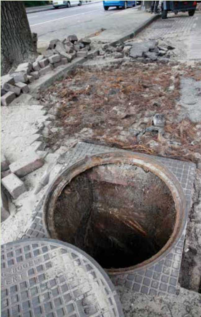
Ingroei van wortels in rioolpunt via scheuren in voegverbindingen.
