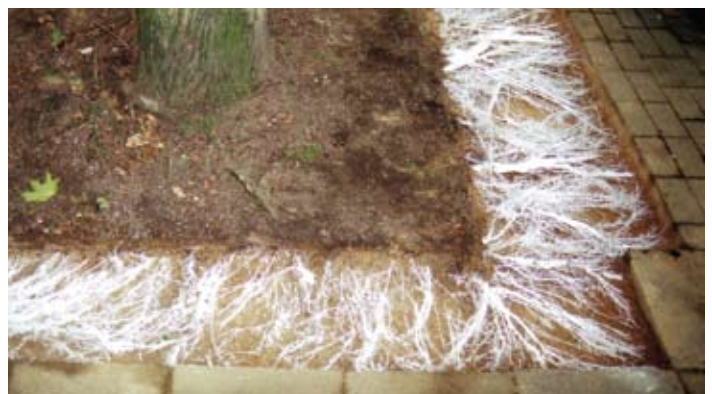
Foto 2 Goed verdeelde fijne beworteling onder de elementverharding (wit ingekleurd)
