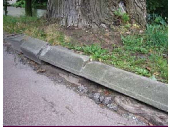
Foto 4 Opsluitbanden op hout gefundeerd
